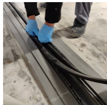
Vlepení dilatační pryže do spárového profilu MC-Floor Connect CPS
