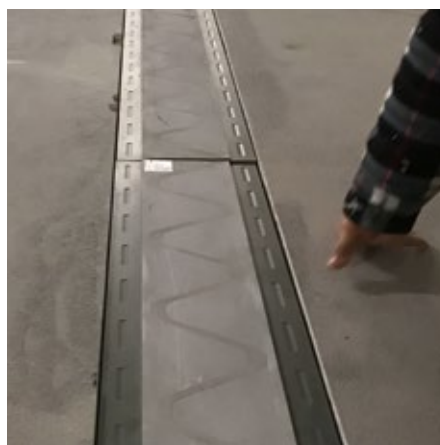
Zabudování spárového profilu MC-Floor Connect CP
