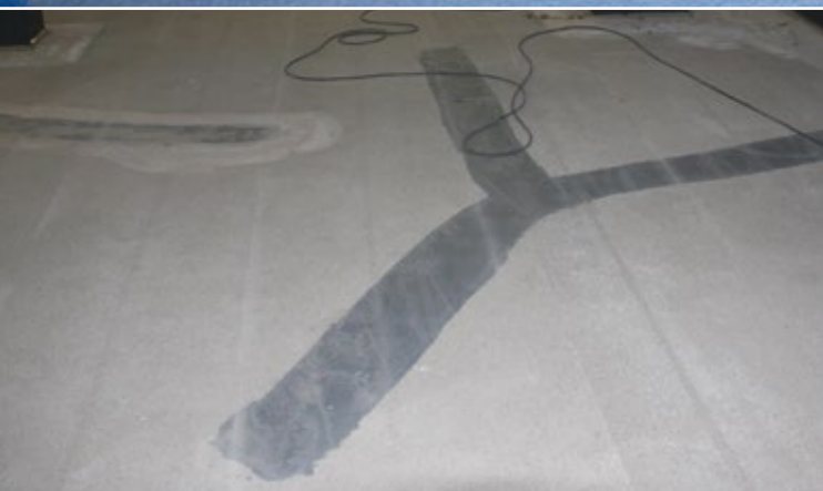
Bandáž pro přemostění trhlin před konečným podlahovým souvrstvím
